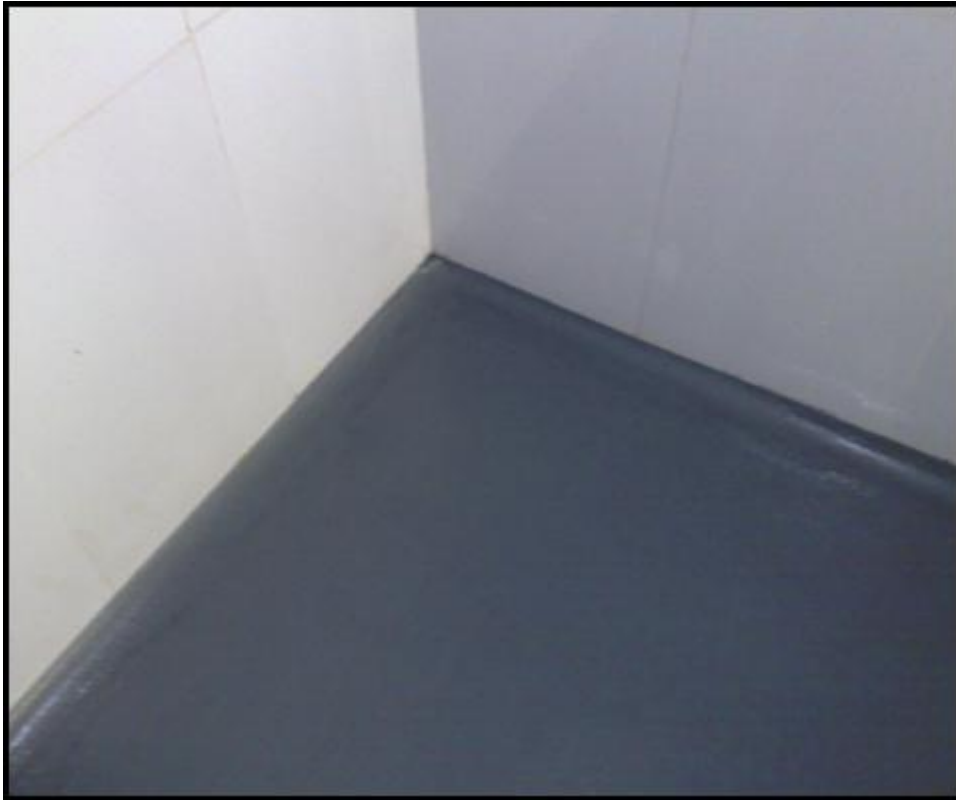
Cocina con multicapa antideslizante y zócalo media caña
