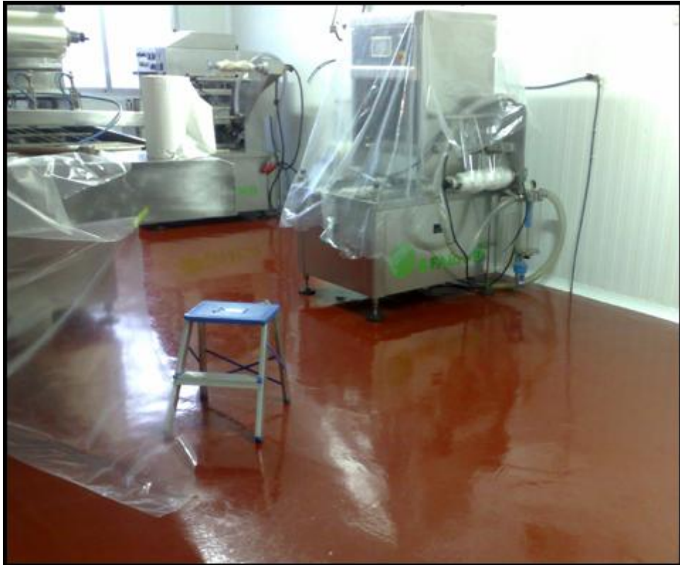
Obrador con mortero seco de resina
